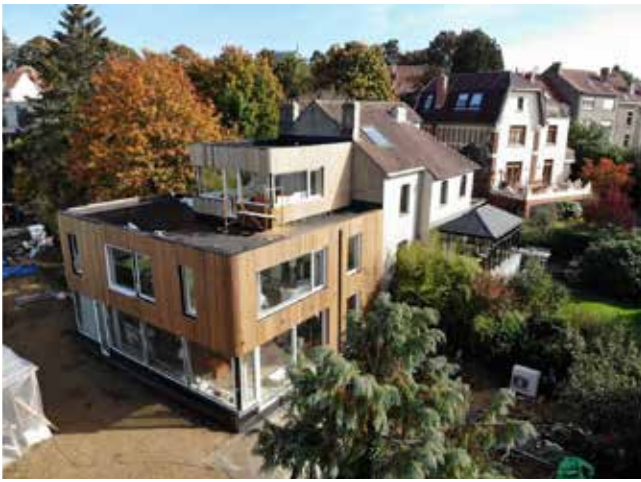
Villa d'architecte R+2 constituée de 13 modules 3D Icontech, assemblée en 3 jours
