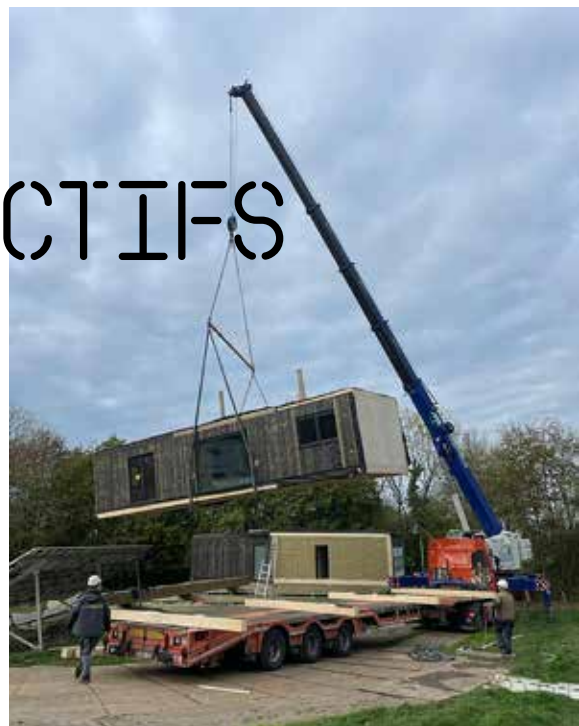
Stabilame – pose module – maison 160m 2 en 3 modules
