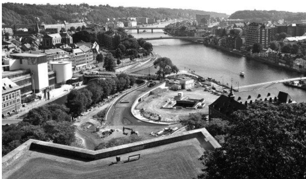
Le chantier du Grognon, à Namur. © belga image
