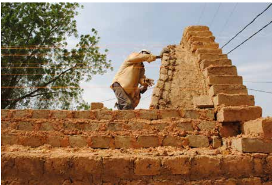
École de couture au Niger / Entreprise : Construction Sans Bois / Technique : Adobe et Voûte Nubienne © photo Odile Vandermeeren
