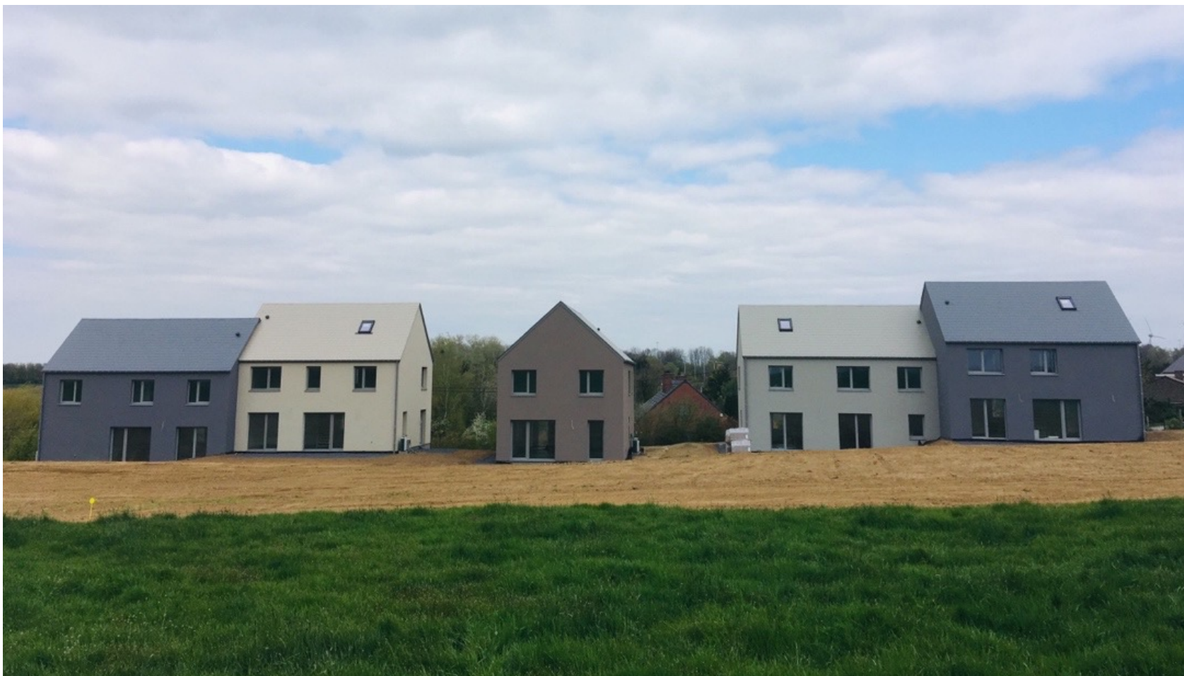
Ensemble de maisons d'habitation © Urban Architectes
